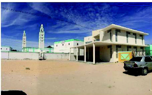
Vista General del Centro Oftalmológico Edificio Yacoub Al Nafisi
